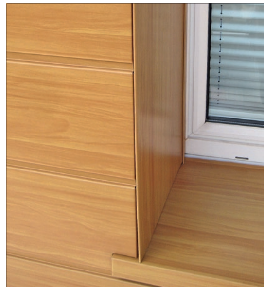
Fassadenbekleidung Metall Prefa Siding
