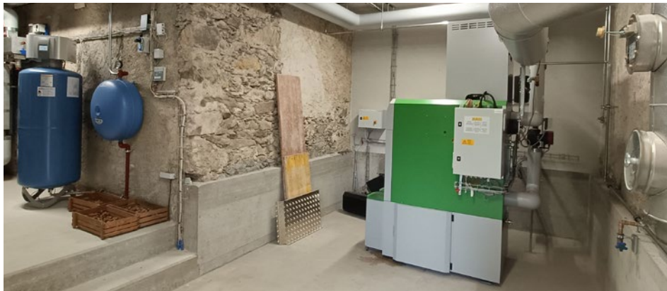
Zentrale Schnitzelheizung
