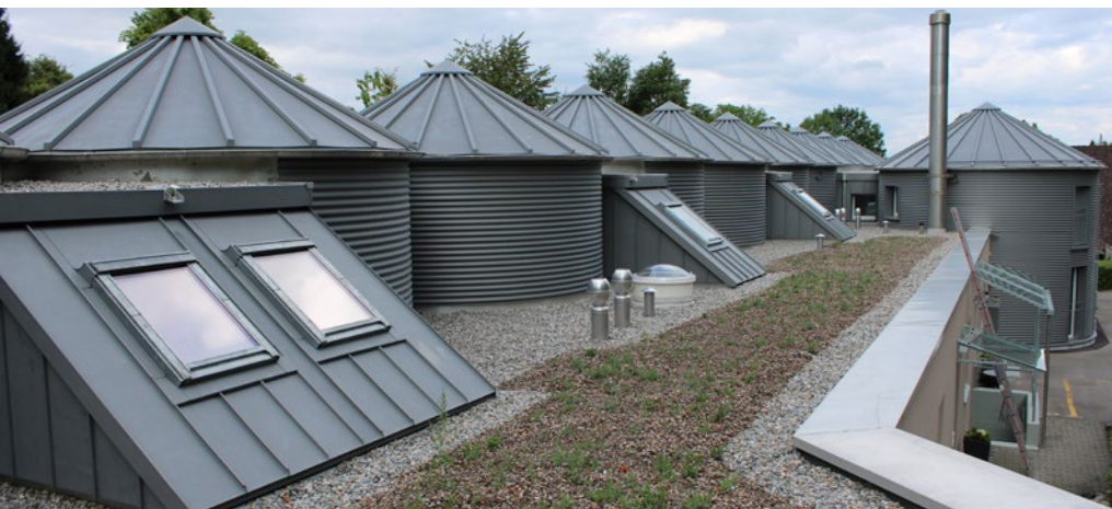
Ansicht, welche die vielfältigen Spenglerarbeiten zeigt
