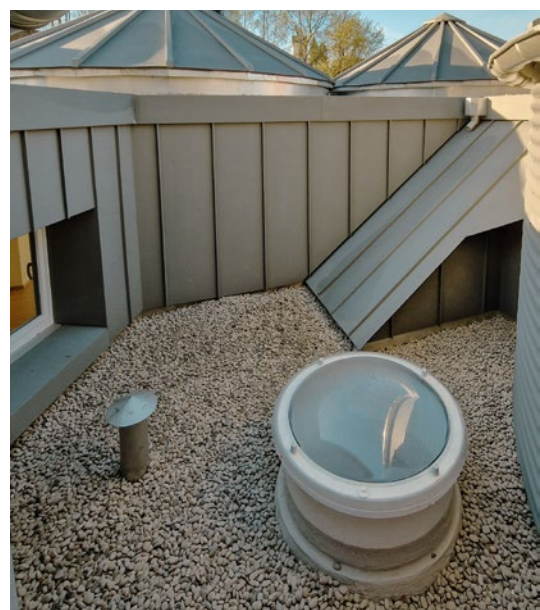
Detailarbeiten auf kleinstem Raum (Flachdach, Winkelstehfalzfassade und Leistendach)
